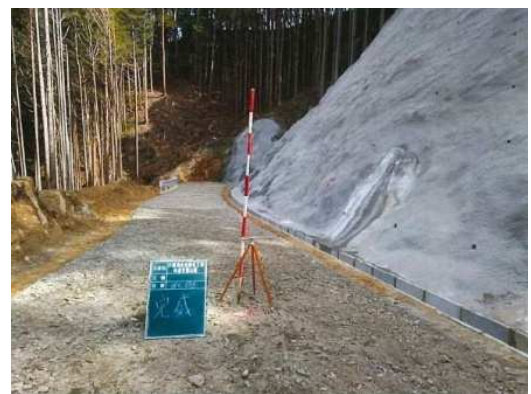
林道笹頭山線 開設状況
