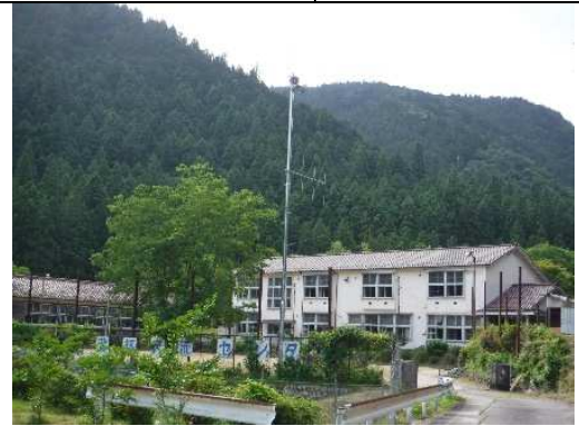
防災行政無線（同報系）屋外拡声子局増設工事（豊邦地区）
