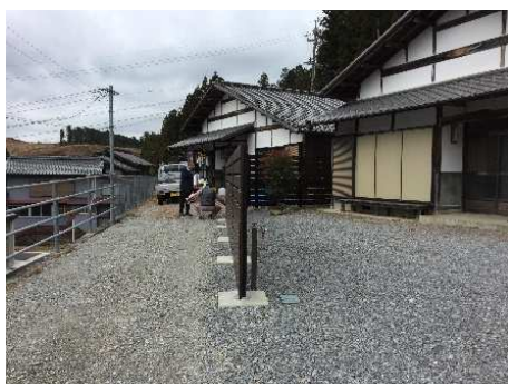
新たに改修した杉平南住宅囲障フェンス
