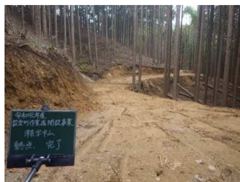
現場写真（作業道開設後：中山②線）
