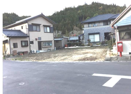
危険空家（解体後）
