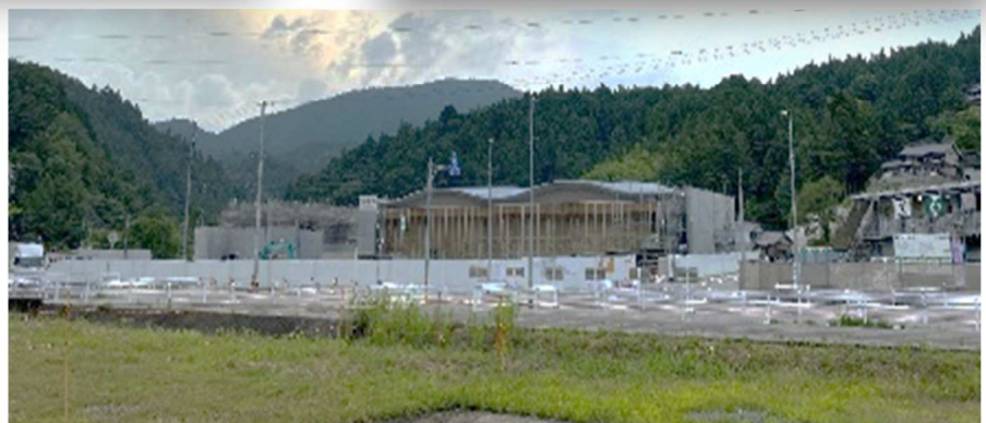
工事が進む「道の駅したら」
